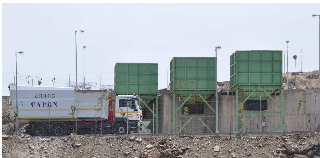
Εικ. 4.3: Άποψη των 3 χοανών ΣΜΑ (κάτω επίπεδο) & μεταφορά container από Ο.Μ. Hook lift
