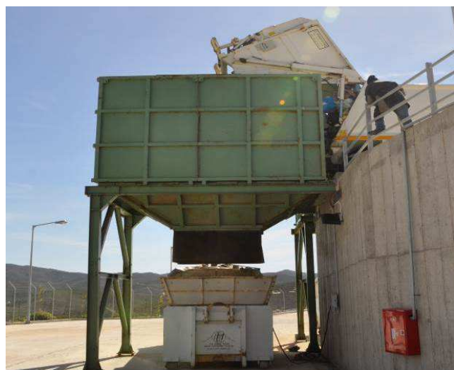
Εικ. 4.4: Διαδικασία πλήρωσης press container μέσω μεταλλικής χοάνης
