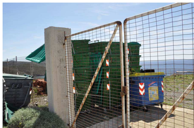
Εικ. 4.8: Καινούργιοι αποθηκευμένοι κάδοι, ως απόθεμα, εντός του χώρου δεξαμενής ύδρευσης
