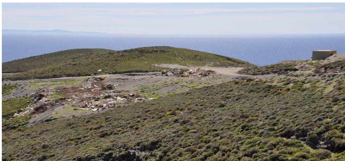
Εικ. 4.13: Χώρος εναπόθεσης ογκωδών έξω από τον αποκατεστημένο ΧΑΔΑ «Καστρί»
